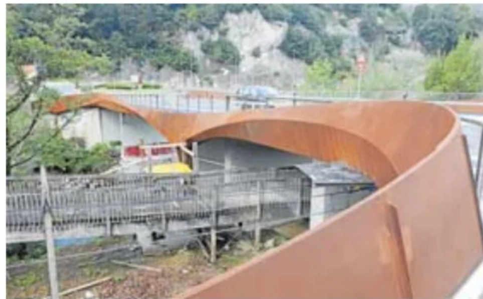
Vista del nuevo puente, con el paso peatonal pendiente de renovar. J. LEON
