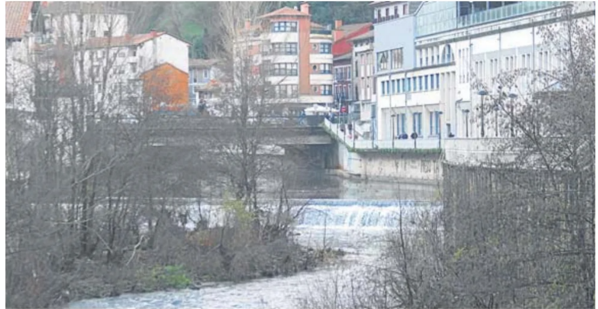
La presa de Olabarrena, situada al paso del río Deba por el centro de Soraluze, se queda de momento fuera del proyecto Merlín. J. LEON
