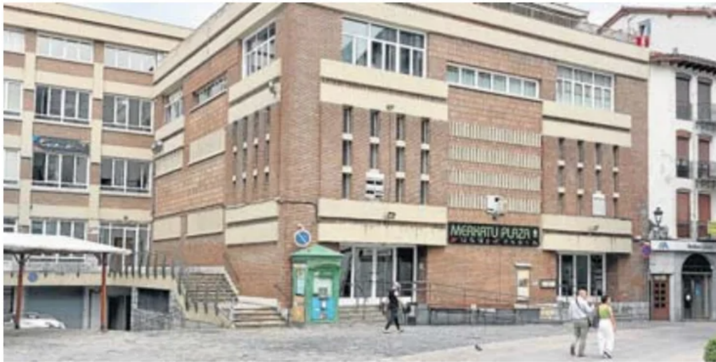
Vista del edificio de la plaza del mercado, que será demolido para construir el nuevo ambulatorio. J. LEON
