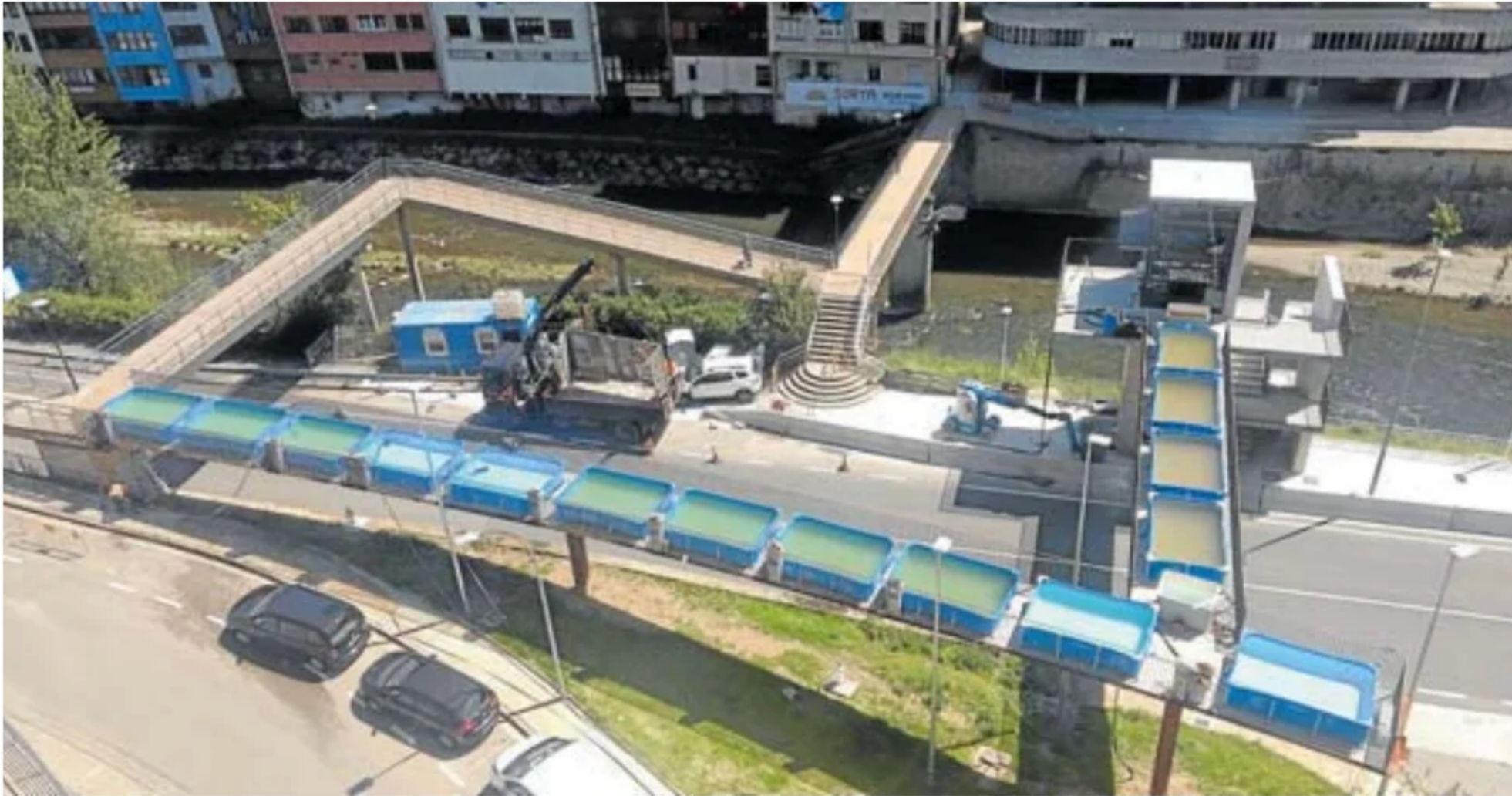
Varias piscinas llenas de agua en las nuevas pasarelas instaladas en el puente, durante la prueba de carga del pasado día 9 de mayo. J. LEON
